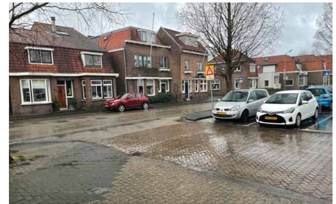
Aanzicht Middeldiepstraat vanaf het plein
