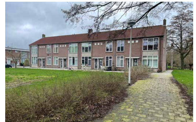
Bestaande bebouwing binnen het plangebied
