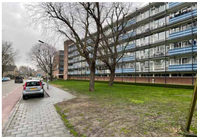
Aanzicht huidige bebouwing vanaf de Rembrandtlaan
