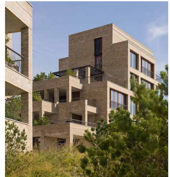
Dak ingericht als terras direct grenzend aan woning
