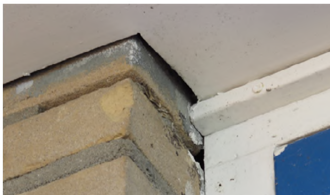
De kieren tussen de bakstenen gevel en het houten boeiboord bieden potentie voor vleermuizen
