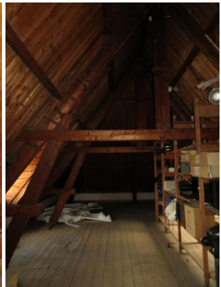
Zolderruimte boven de westvleugel.
