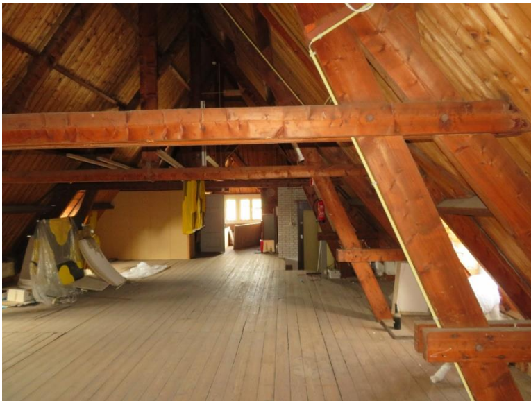
Westelijke grote zolderruimte.
