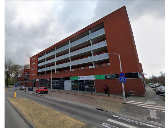
Thorbeckelaan, appartementencomplex van 5 lagen
