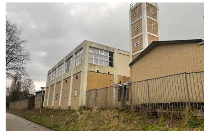
De achterkant van de kazerne aan de Gantelweg
