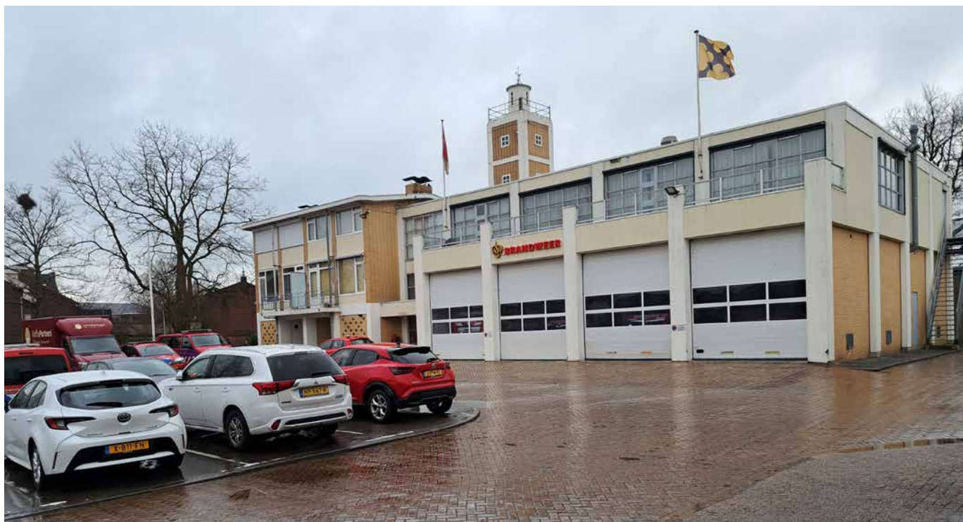
Aanzicht huidige brandweerkazerne en plein
