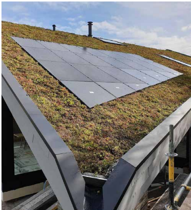
Schuin natuurdak gecombineerd met energieopwekking
