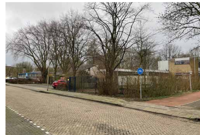
Te slopen bebouwing langs de Maaslaan
