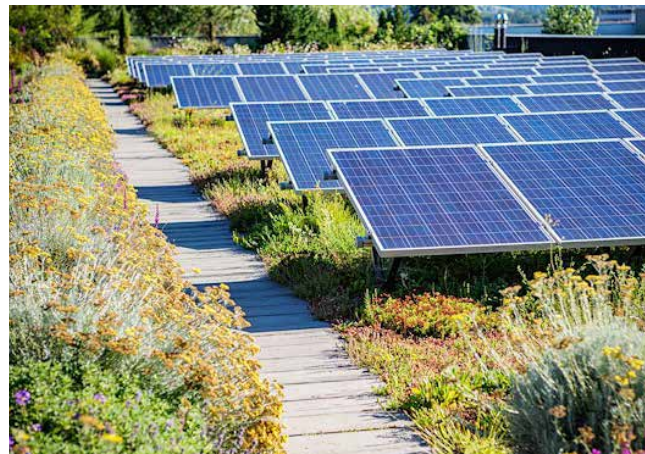
Natuurdak gecombineerd met energieopwekking
