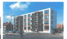
BLOK D - RENOVATIE GEREALISEERD
