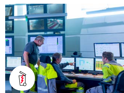
energieproductie uit restafval
